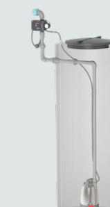
Montage dans la citerne
